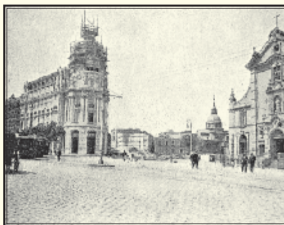
Entrada de la Gran Vía.
