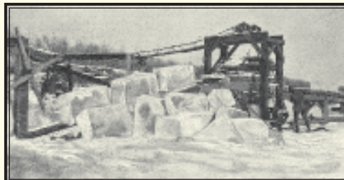
Elevador con plano inclinado y cadenas de transmisión.
